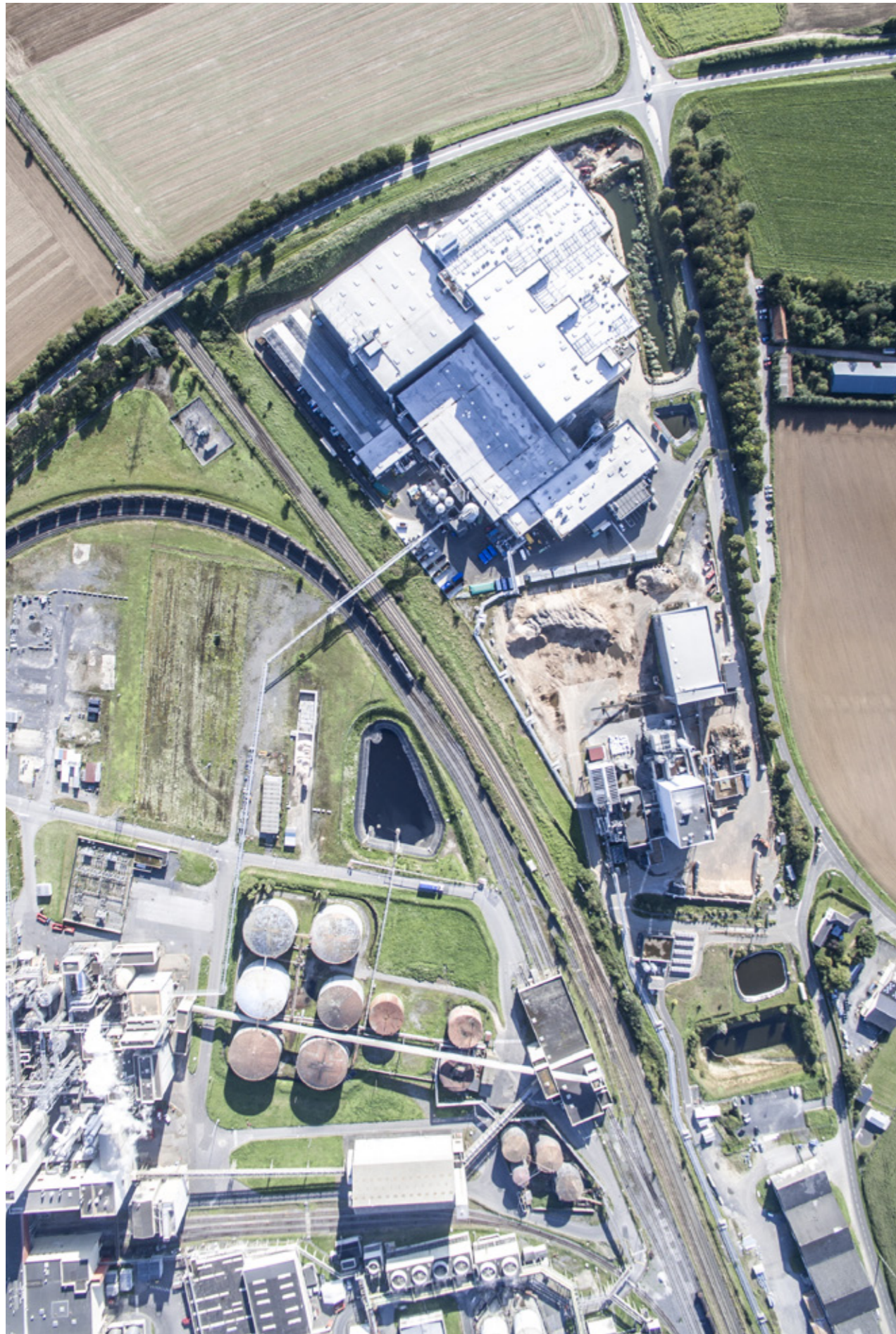
Vue aérienne des installations d'Innovafeed, Tereos et Kogeban à Nesle, France
